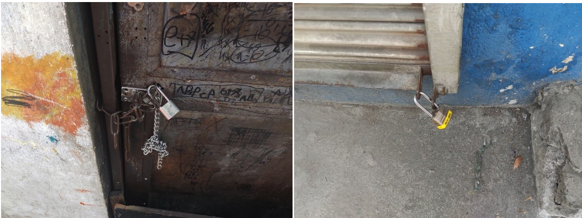
【写真 4: 施錠状況】
