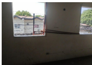
【写真 9: 梯子固定方法確認】
